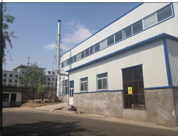
碳酸锂车间排气筒
